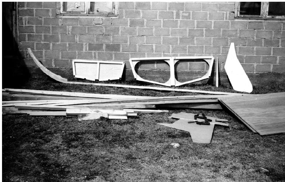
Kölplanka med stäv, akterspegel och 0-spant, roder och virke till spant mm
