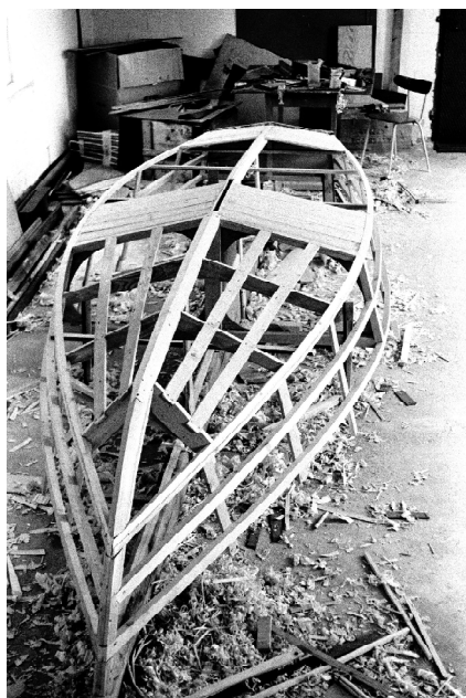
Centerbordslådan är redan monterad, liksom bordläggningen av trä i botten på båda sidor om den
